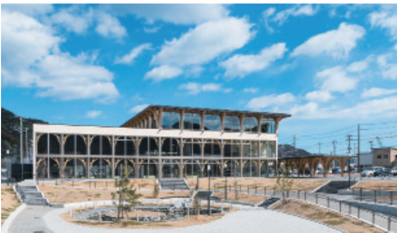
岩手県にある大槌町文化交流センターは、3階建て・ガラス張りの大規模木造建築
