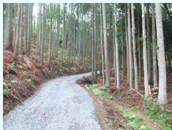
作業道の作設
