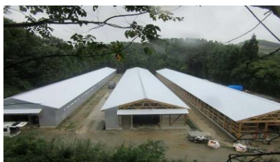
新設した鶏舎
