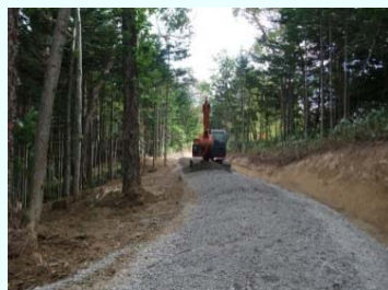
作業道の作設風景
