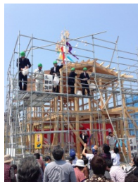
災害公営住宅上棟式
