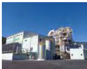
ファンド出資先の発電所
