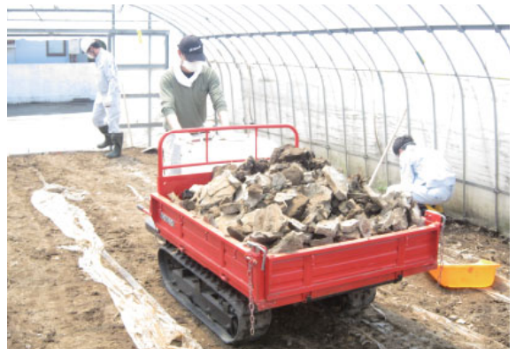
イチゴ農家のハウス内ガレキ撤去
