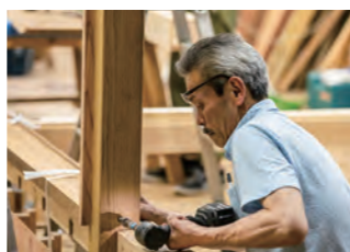
一度仮組をしておけば、海外でも施工がしやすくなる。
