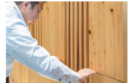
工場ブロックごとのパネルにして、現場に持ち込み、細部を調整してネジで止めている。節も何箇所と埋木をします、誰にも知られていませんが。
