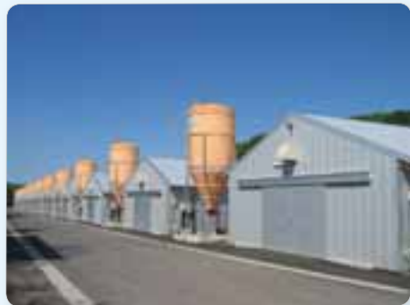
(株)十文字チキンカンパニー：鶏糞バイオマス発電事業（シンジケート・ローン対象）
