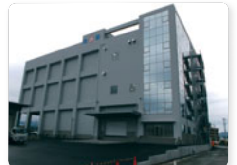
気仙沼漁業協同組合:冷蔵・製氷施設外観 (復興ローン対象)
