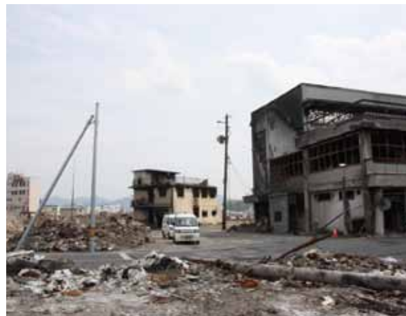
被災直後の JA 新いわて山田支所
