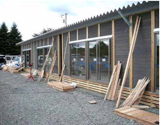
田村森林組合が資材を供給する仮設住宅(福島県)
