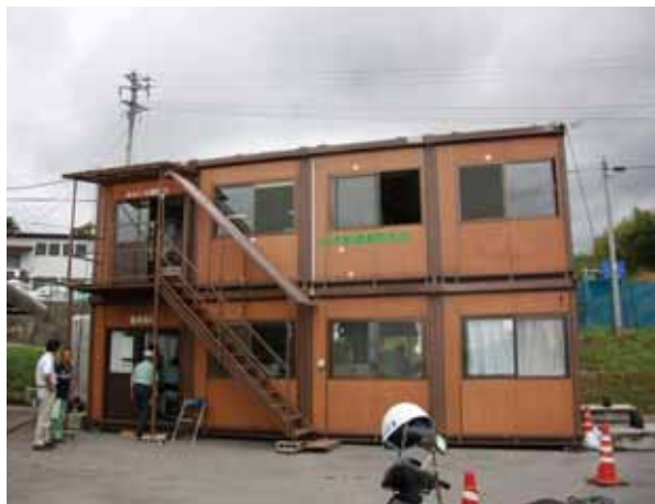
仮設店舗で営業を再開した JA おおふと高田支店
