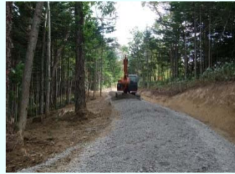
作業道の作設風景
