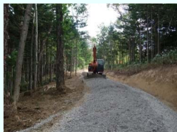
作業道の作設風景
