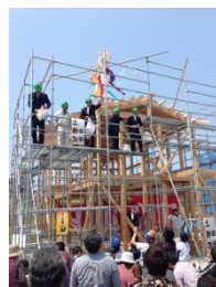
災害公営住宅上棟式
