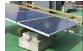
【間伐材を利用した架台】
