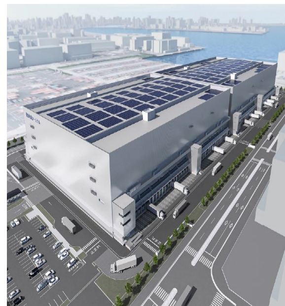
▲建替後冷蔵倉庫イメージ (2027年度竣工予定)
