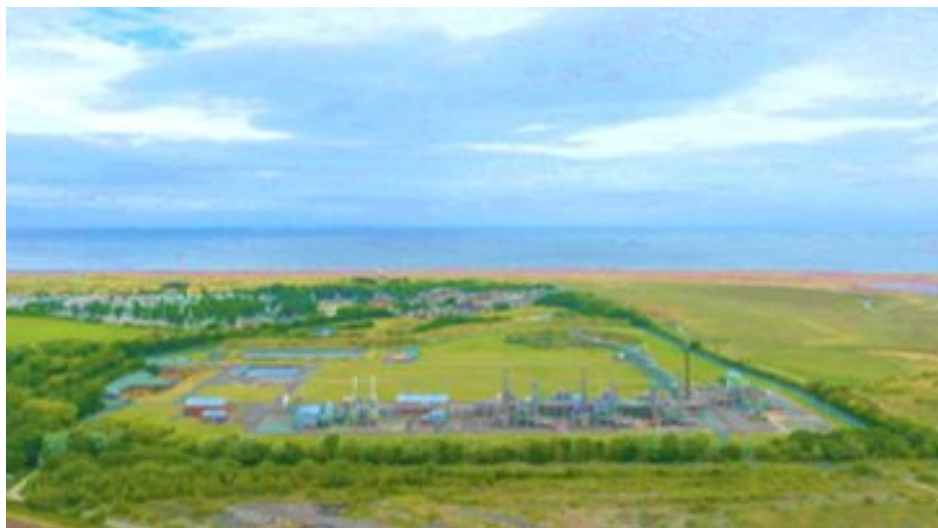
プロジェクト関連のCO2輸送・貯留施設
