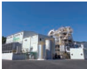
ファンド出資先の発電所
