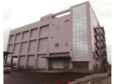
復興ローン等を活用し, 平成24年10月に稼働した気仙沼漁協の大型製氷施設
