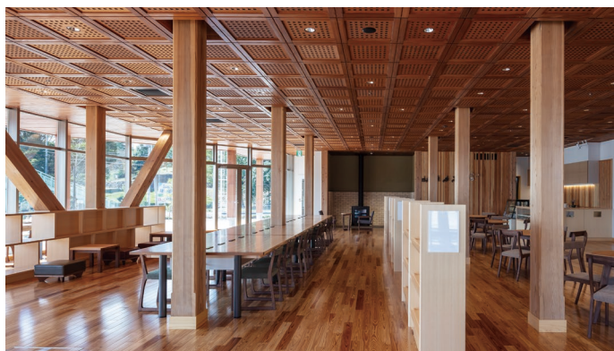
議会棟1階の交流ラウンジ。町民の憩いの場としてブックカフェを整備。柱には組立柱と集成材を用いる(撮影：小川重雄)
