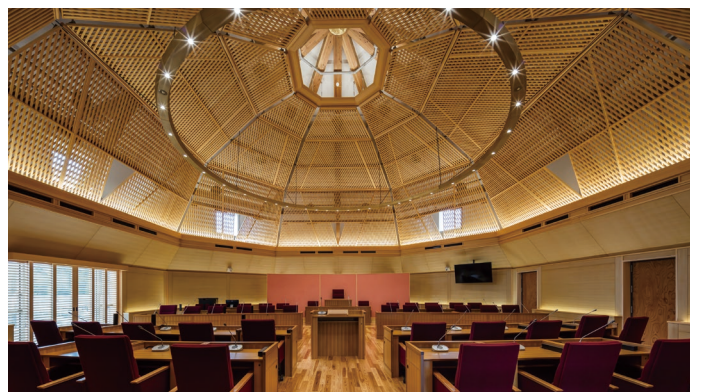
議会棟2階の議場。このような大空間の確保には集成材や鉄骨造も組み合わせている(撮影：小川重雄)
