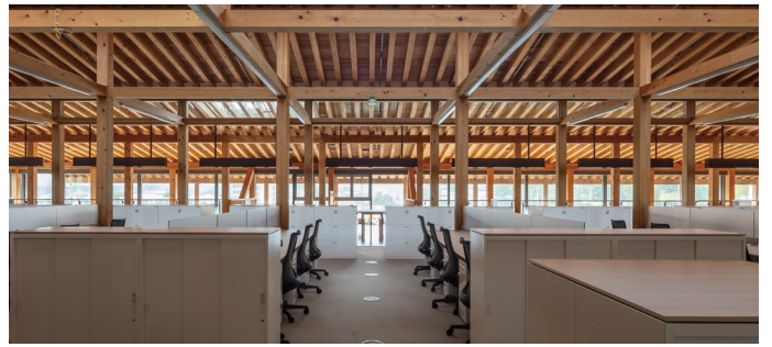
執務棟2階の執務室。手前の中央部はレイアウト変更に対応できるように無柱とした(撮影：小川重雄)
