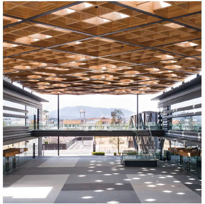
屋根架構は鋼材と集成材の混構造。屋根面には所々トップライトが抜け、木漏れ日のような明かりを床面に落とす（写真：ヴィブラフォト／浅田美浩）
