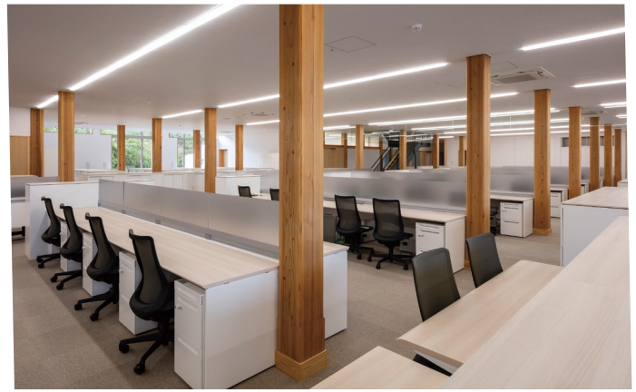
執務棟1階の執務室。主要構造部を準耐火構造とし、スプリンクラー設備を設置することで空間を広々と確保できた（撮影：小川重雄）
