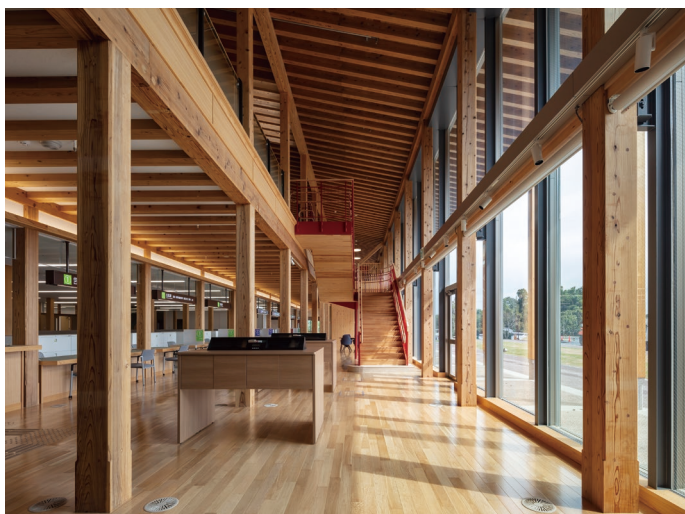
執務棟1階の待合ロビー。製材品を2枚束ねた組立柱のほか、合わせ梁を用いる（撮影：小川重雄）
