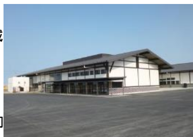
再建された水産加工場
