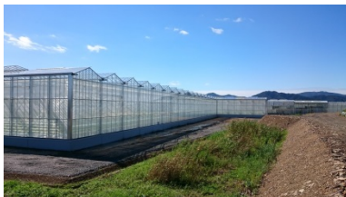
新設された植物工場
