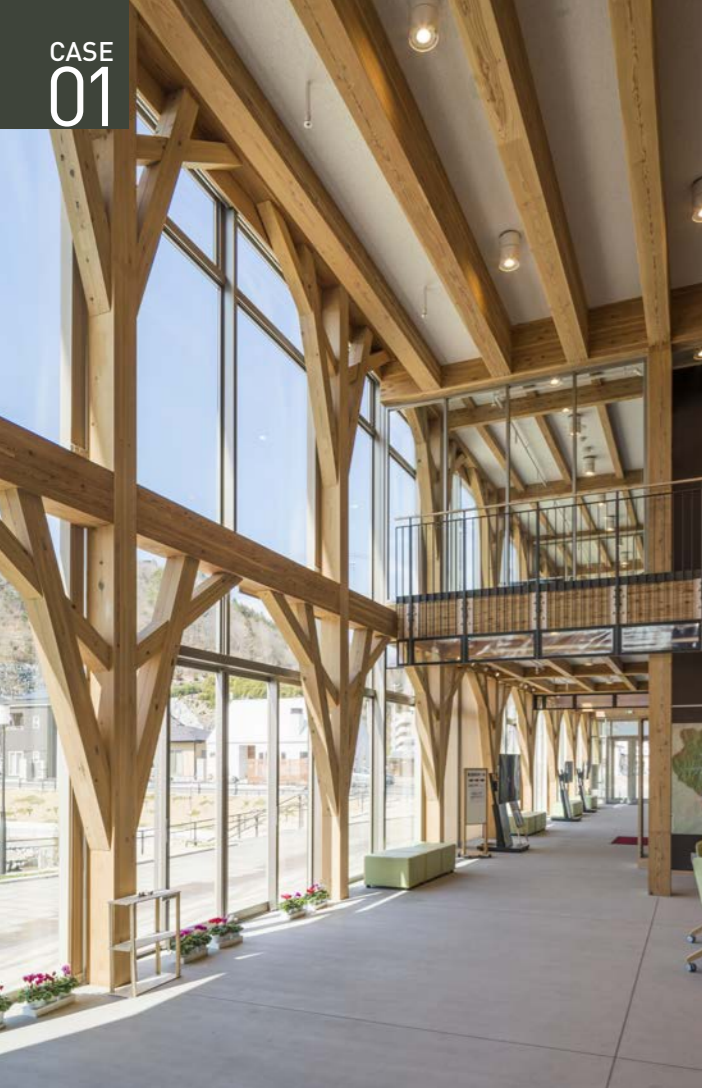
2層吹き抜けのエントランスホール。3層通し柱による連続門型アーチ架構で、開放的な大空間を確保できるつくりを採用した
