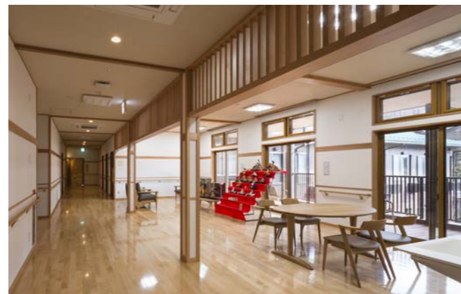
2階交流ラウンジ。化粧竿縁のように構造材の梁を一部現しとしている。コストを考慮しながら木質を感じるしつらえを目指した
