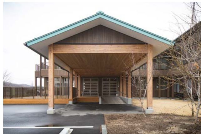
正面のエントランスに至るアプローチ。屋根を支える柱や天井に相当する部分には県産材のカラマツを用いている
