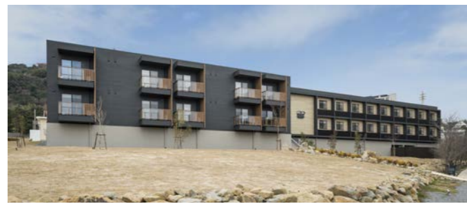
サウスアームの建設は当初計画していなかったが、イーストアームやウエストアームが高稼働を続けていたことから、客室を増やす狙いで建設を決めた
