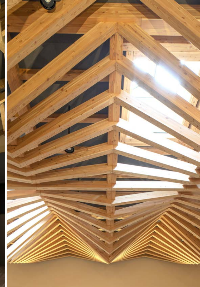
1階多目的ホール。136の移動観覧席を用意できる広々とした空間には柱が1本もない。通常なら断面の大きな集成材で組み上げるが、コストの抑制と音響面の性能向上を目指し、経済的に調達できる細径の木造部材を互いに支え合う構造を採用した。複雑な構造だが、地上で組んだうえで、わずか1日でつり上げたという
