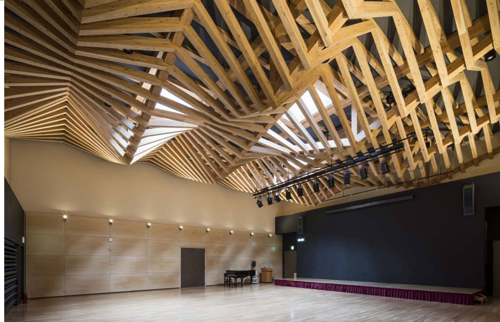
1階多目的ホール。136の移動観覧席を用意できる広々とした空間には柱が1本もない。通常なら断面の大きな集成材で組み上げるが、コストの抑制と音響面の性能向上を目指し、経済的に調達できる細径の木造部材を互いに支え合う構造を採用した。複雑な構造だが、地上で組んだうえで、わずか1日でつり上げたという
