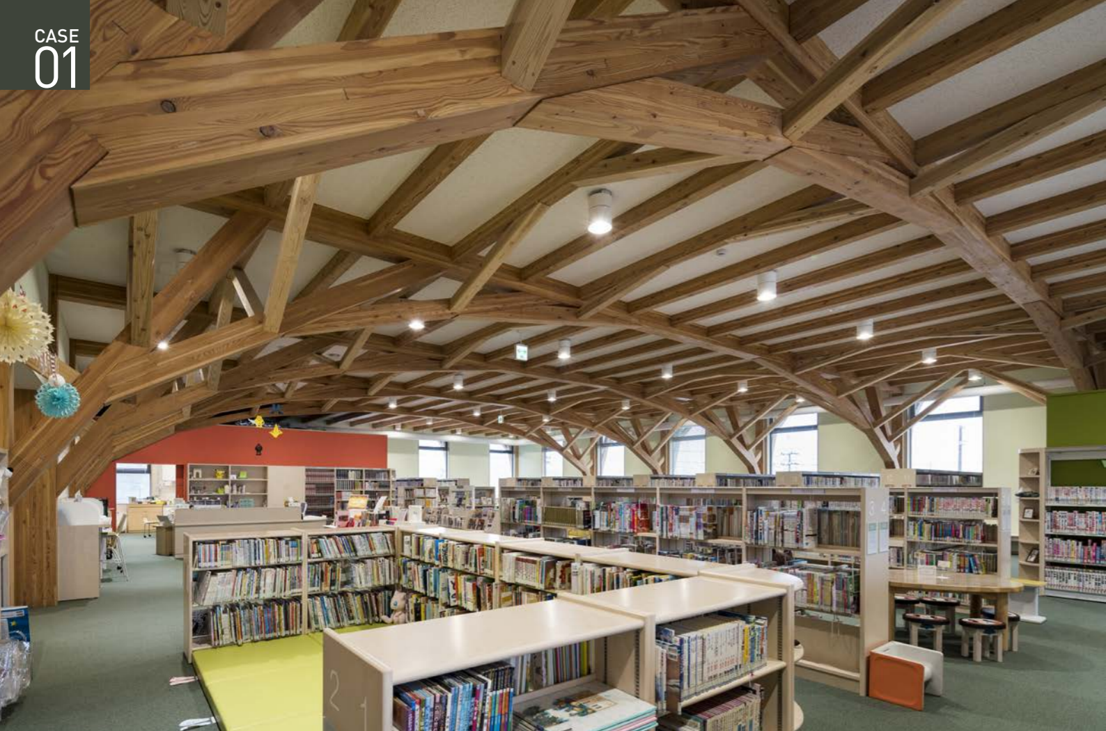
3階図書館。書架を自由に配置できる広々とした空間を確保し、天井からの圧迫感を避ける狙いから、樹木の幹や枝で天井を支えるように見える構造形式を採用した。町の基本計画ではこれだけ広い開架書架スペースは確保できていなかった。蔵書数は約3万7000冊。右手には、窓際に学習コーナーを配置している
