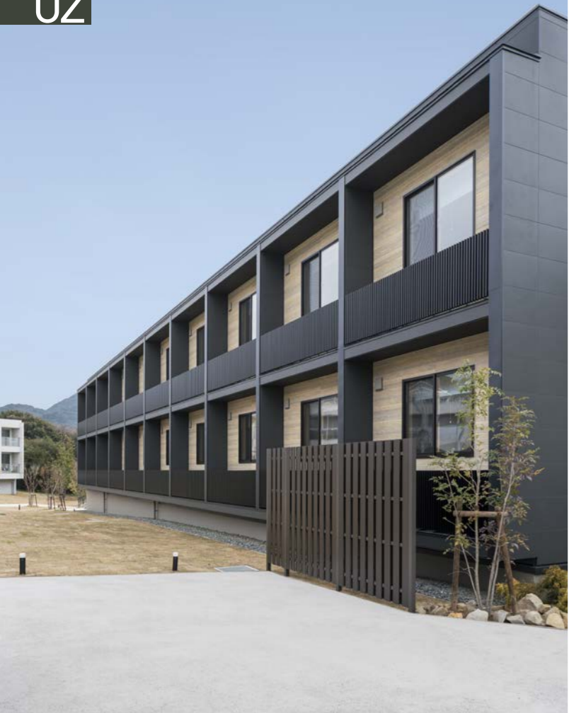
サウスアーム (3期棟) コストを抑える狙いから、戸建て住宅と同じように柱や梁で骨組みをつくる一般的な木造を採用。窓周りは木材のように見えるサイディングという外装材。外部には木部を露出させていない
