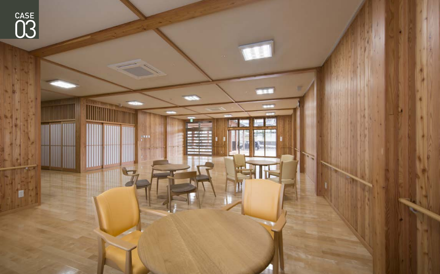
1階交流ホール。壁は県産材のカラマツで仕上げた。天井に見えている木材のうち太いほうは構造材の梁、細いほうは表情に変化を持たせる狙いから取り付けた化粧材。このホールは特別養護老人ホームとは独立して利用することを想定しているため、正面に見えるように専用の出入口を備えている
