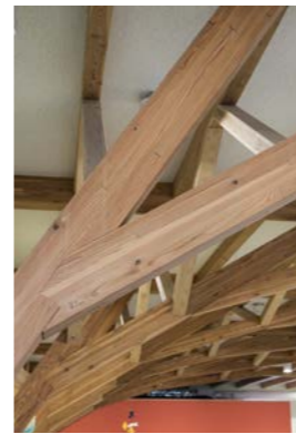
柱と梁の間に加える補強のための部材を建築では「方杖(ほうづえ)」と呼ぶ。この方杖には、町産材であるスギでつくられた集成材を用いた
