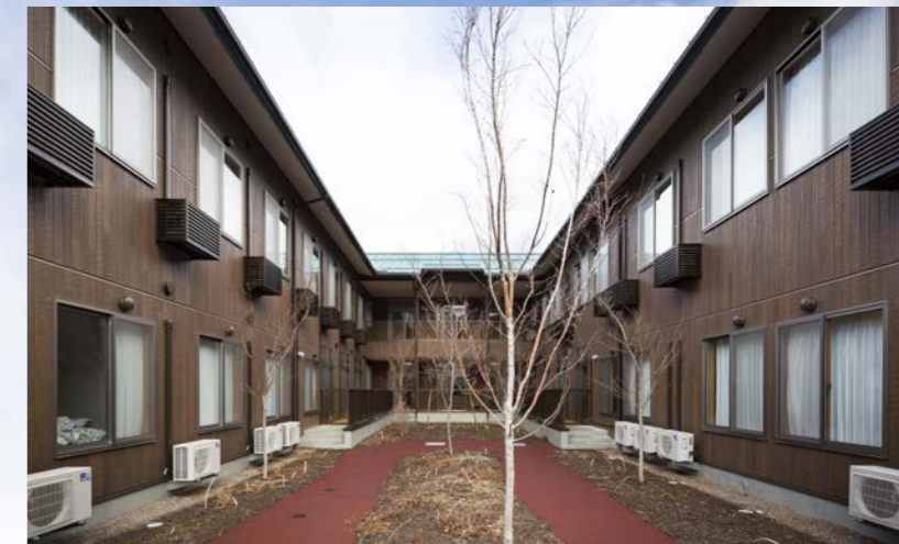
左の個室ユニットと右の多床室ユニットに挟まれた中庭。正面には、ウッドデッキの向こうに交流ラウンジが広がる。中庭を挟むことでより多くの居室で採光・通風を確保できるようにしている
